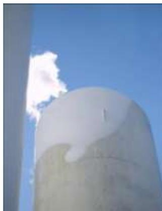
Lorsqu'il se produit une perte totale de vide par le récipient interne, le réservoir doit être retiré du service aussi vite que possible. Le réservoir doit être sécurisé en le décomprimant à l'atmosphère quelle que soit la quantité de liquide restant dans le réservoir. La perte de vide par le récipient interne
