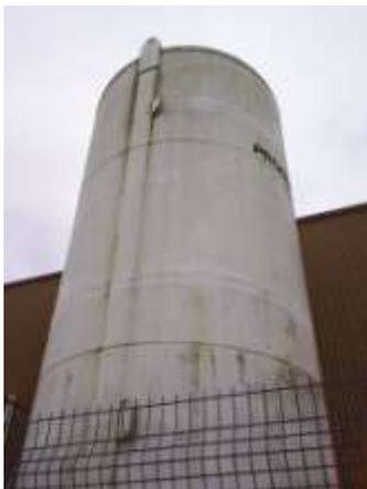
Lorsque l'on suspecte une perte significative de vide le propriétaire du récipient doit en être averti aussi vite que possible. Le propriétaire du récipient doit contrôler le vide et rectifier tout défaut de vide dès que cela est possible.
